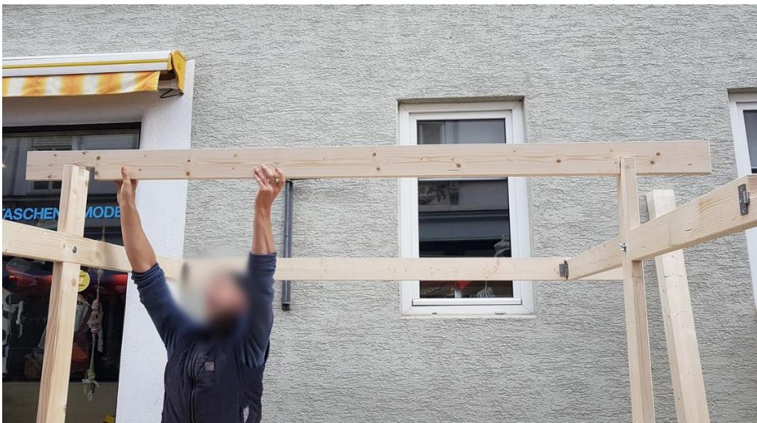
Dachgiebel einsetzen. Holzverbindung „einrasten“.
