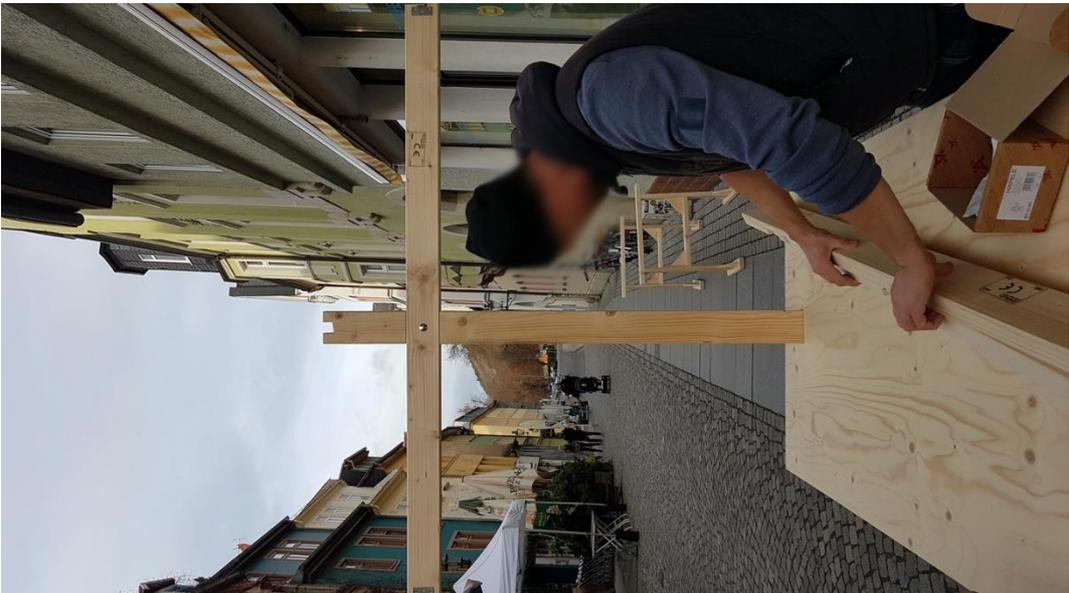
2 Querträger an den 2 Pfosten befestigen (Schrauben mit Flügelmutter).
