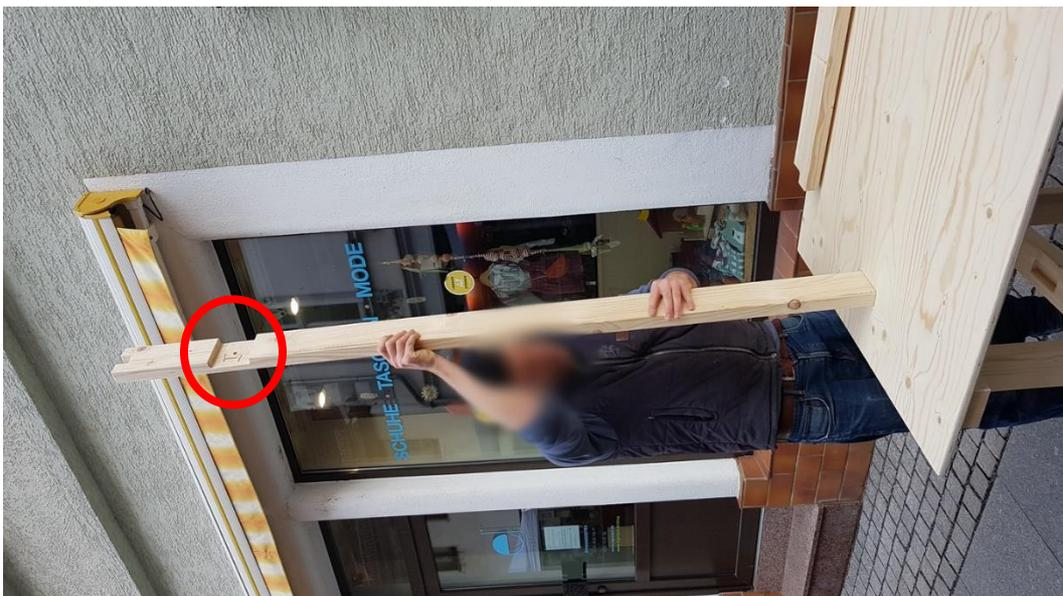
Pfosten (2 Stück) senkrecht links und rechts in Tischplatte und in die darunter stehenden Böcke versenken. Vertiefung für Holzverbindung zeigt nach innen.
