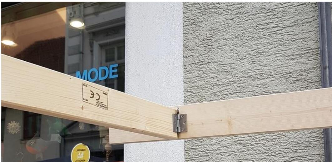
Bretter zur Befestigung des Stoffdaches an den Querträgern einhängen (Sicherungsstifte).
